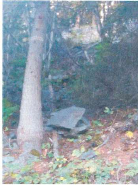
Pierres en suspension entre le chemin et la route à la limite de tomber sur la route
